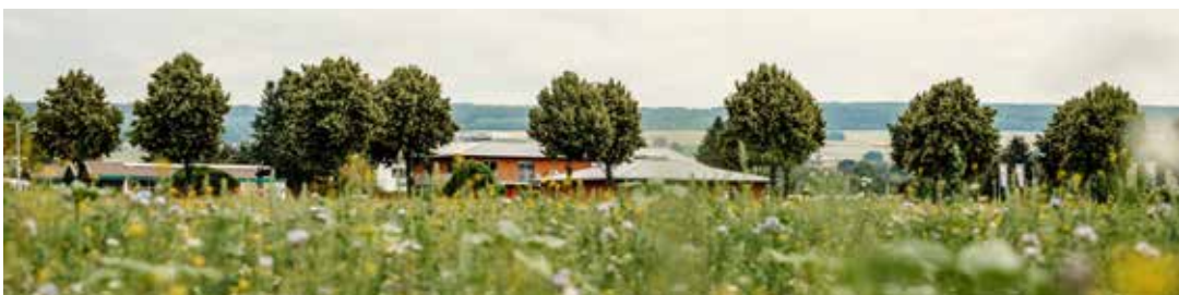
Der Firmensitz der Ölmühle Solling wurde auf einem 14.000 m 2 großen Grundstück neu erbaut.
