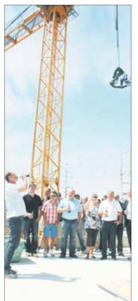
Bauleiter Peter Wagner (links) trinkt einen Schluck auf das Wohl der Bauherrn, Heinrich-Markus Engelke sowie Peter und Burkhard Salzer (Mitte). Foto: Zimmerhof
